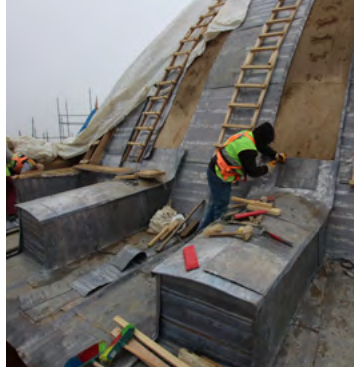
Ana kubbede kurşun kaplama uygulamaları Lead cladding applications on the main dome
