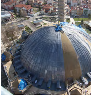
Ana kubbede kurşun kaplama uygulamaları Lead cladding applications on the main dome
