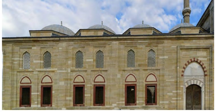
Güneybatı avlu cephesi onarım sonrası Southwest courtyard façade after restoration
