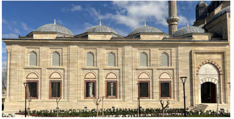
Güneybatı avlu cephesi onarım öncesi Southwest courtyard façade before restoration
